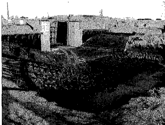
Het maken van een bodemvoorziening van de schutsluis in de afsluitdijk van de Lauwerszee
